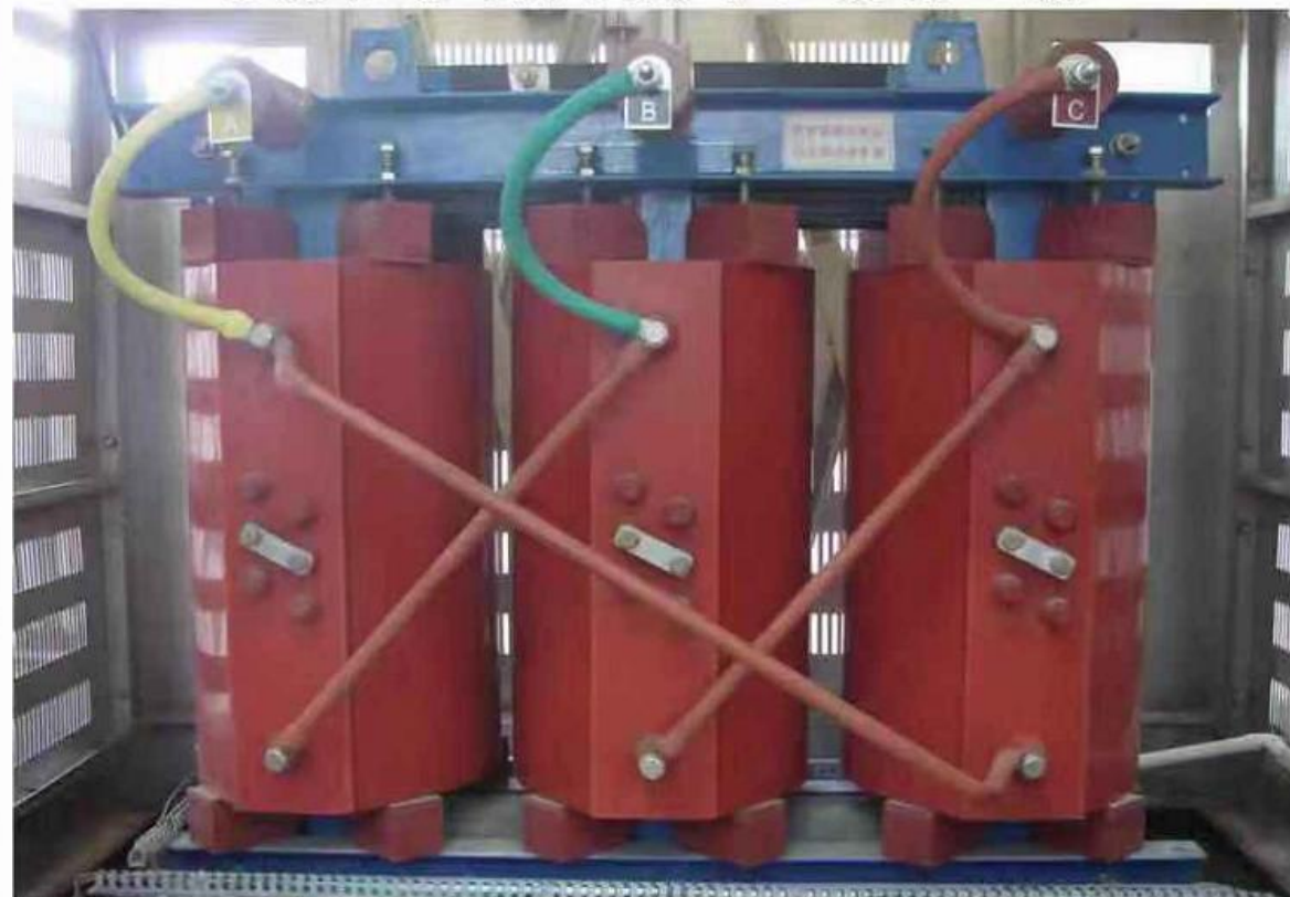
实操考场内的干式变压器
