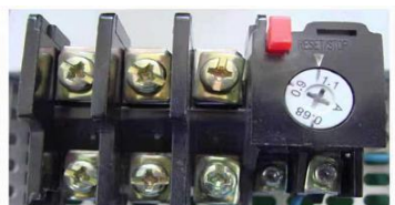
热元件的额定电流为电动机额定电流的1.1-1.25倍， 整定值为1倍（图中整定值为1.05A）
